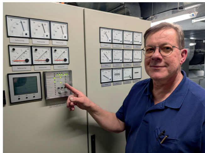
Karlsburg: Ralph Heuer prüft, ob mit der Belüftungstechnik in den Operationsbereichen alles in Ordnung ist.
